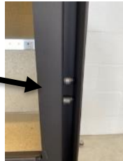
Excentrische afstelschroef deur
