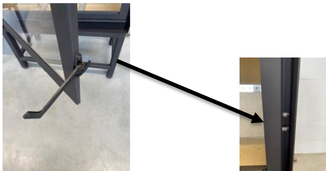
Excentrische afstelschroef deur
