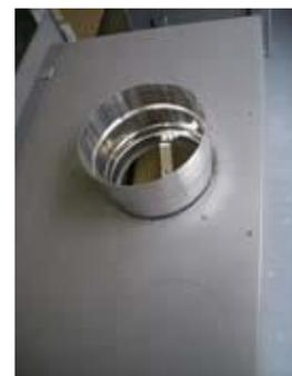
Lorsque le buselot est placé sur l'appareil, replier les 2 pattes de sécurité.
