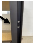
Excentrische afstelschroef deur
